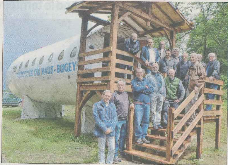
■ L'accès au club house de l'altiport a été entièrement réhabilité par les apprentis de la maison familiale rurale. Photo Guÿ DOMAIN
